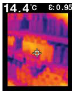
Probleme mit der Kühlung
