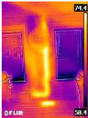
Warmes Abflussrohr in der Wand
