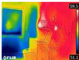
Nicht isolierte Außenwand
